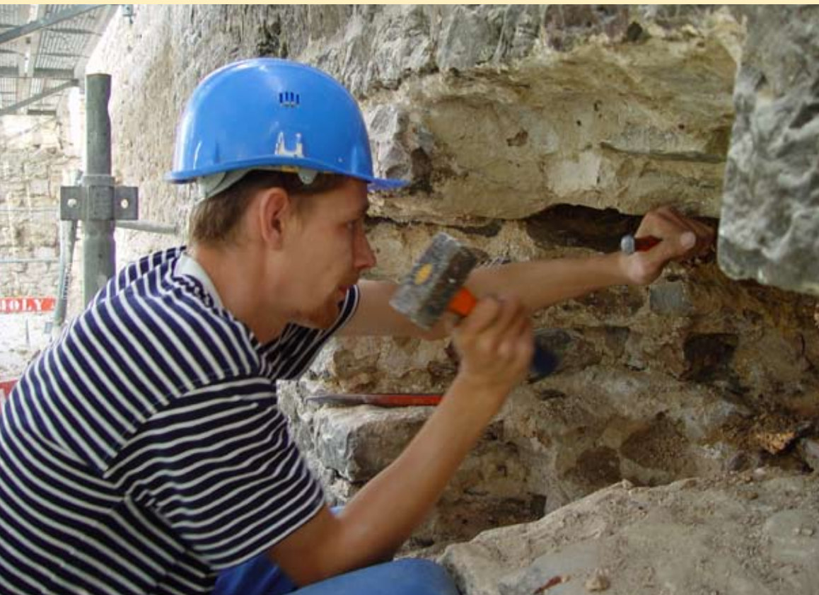
Rénovation des remparts de Boulogne-sur-Mer : un chantier-école au service du patrimoine boulonnais
