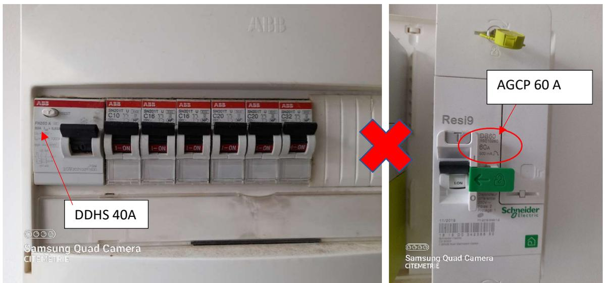
Dans ce cas, l'AGCP à une intensité ( $I_r$ ) unique de 60 A – le DDHS doit donc être de 63 A et non 40 A. L'AGCP peut avoir un  $I_r$  réglable de type 15/30/45 – 30/60 – 15/45 – ... Toujours prendre la valeur la plus haute
