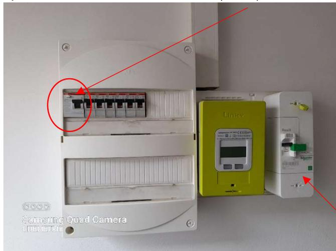
L'intensité du DDHS doit supérieur ou égale à l'intensité maximum réglable de l'AGCP
