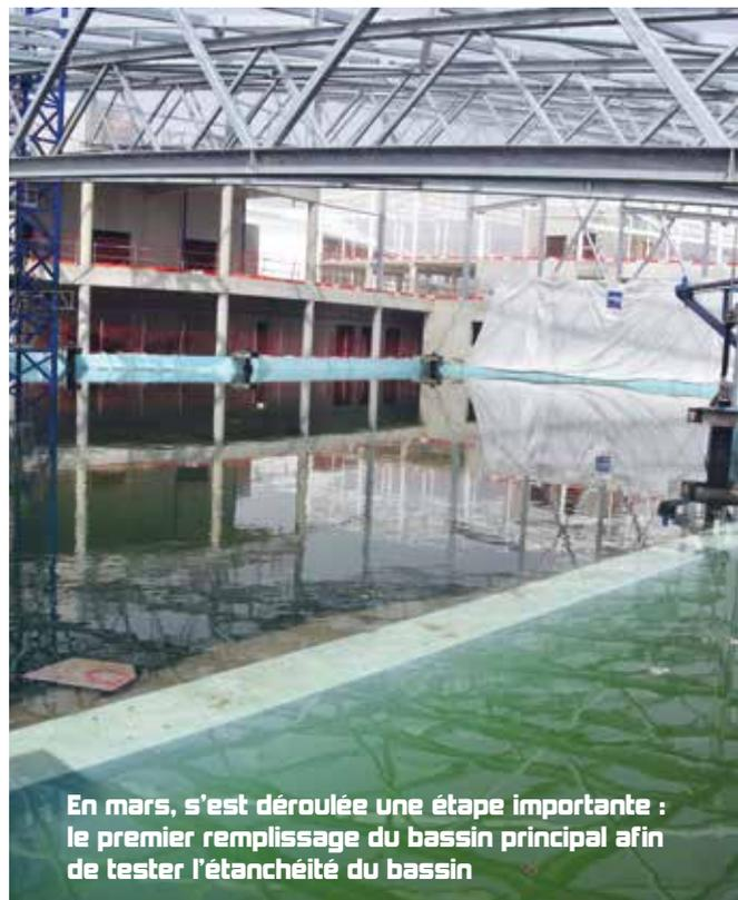
En mars, s'est déroulée une étape importante : le premier remplissage du bassin principal afin de tester l'étanchéité du bassin
