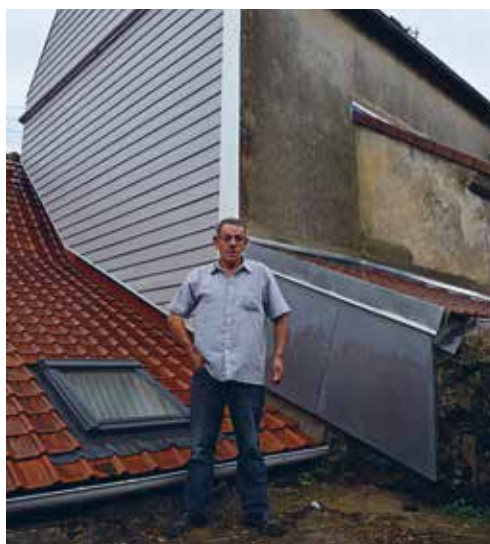
Bernard Morel devant le pignon et la nouvelle toiture
