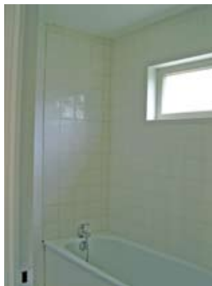
Pièce d'eau rénovée avec l'aide du PIG
